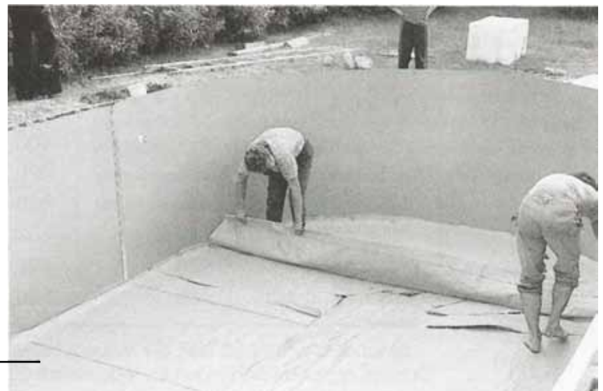
Raum für Magerbeton- Hinterfüllung
